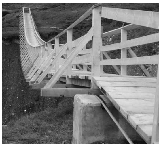
Die eben erst von österreichischen und schweizerischen Zimmermannslehrlingen fertig erstellte Brücke im Valruschna.
